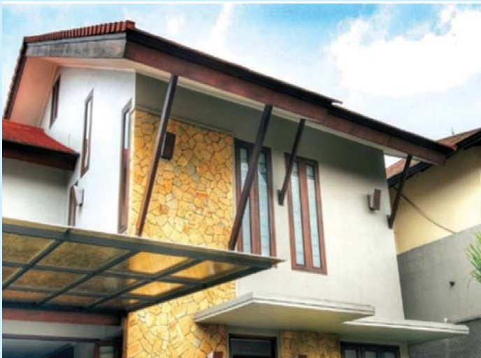
Gambar 1.9: Tiang Penyangga Atap Bangunan
